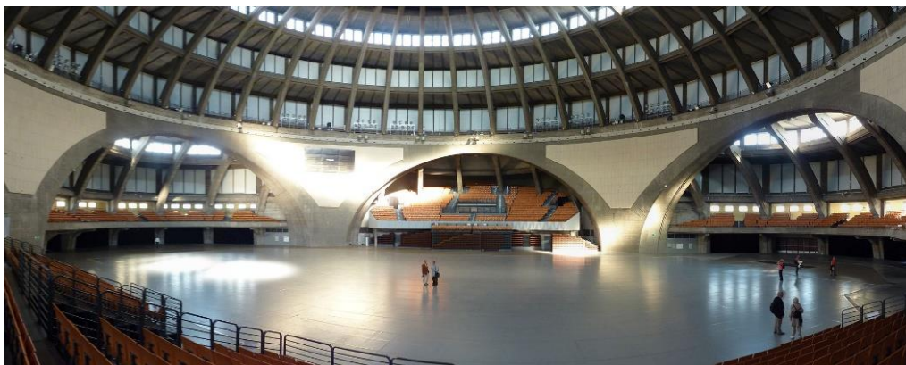
Abbildung 2: Blick in den Innenraum der Halle
