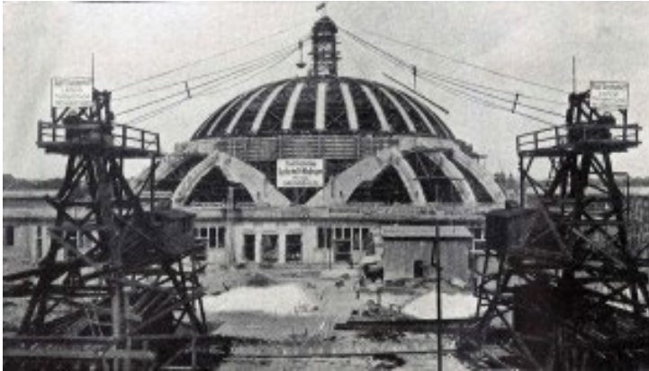
Abbildung 21: Jahrhunderthalle im Bau mit Karussellkranbahn (Foto: Beton und Eisen, 1913).
