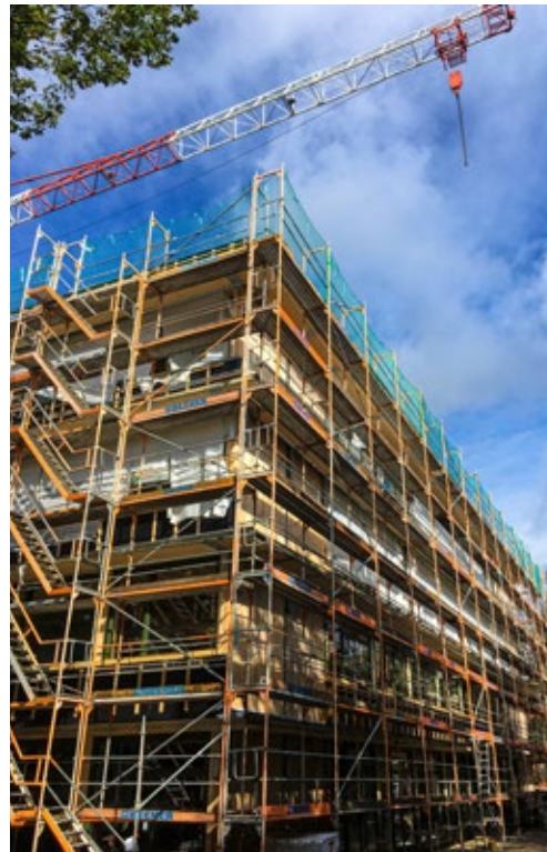
Erweiterungsbau – das neue Kollegiengebäude 1
